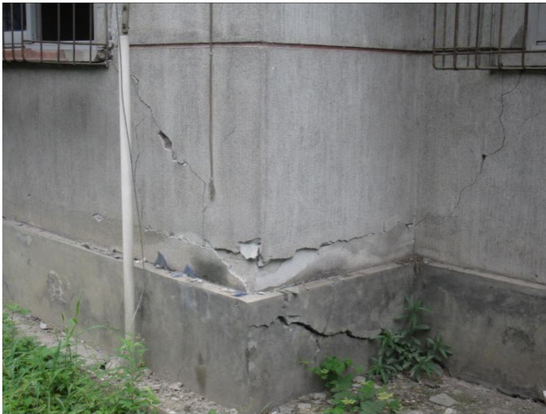
图 4 四川农业大学都江堰校区 23#楼地基沉降使墙体破坏
